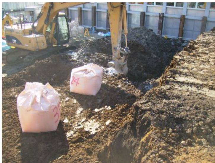
バックホーによる攪拌混合
